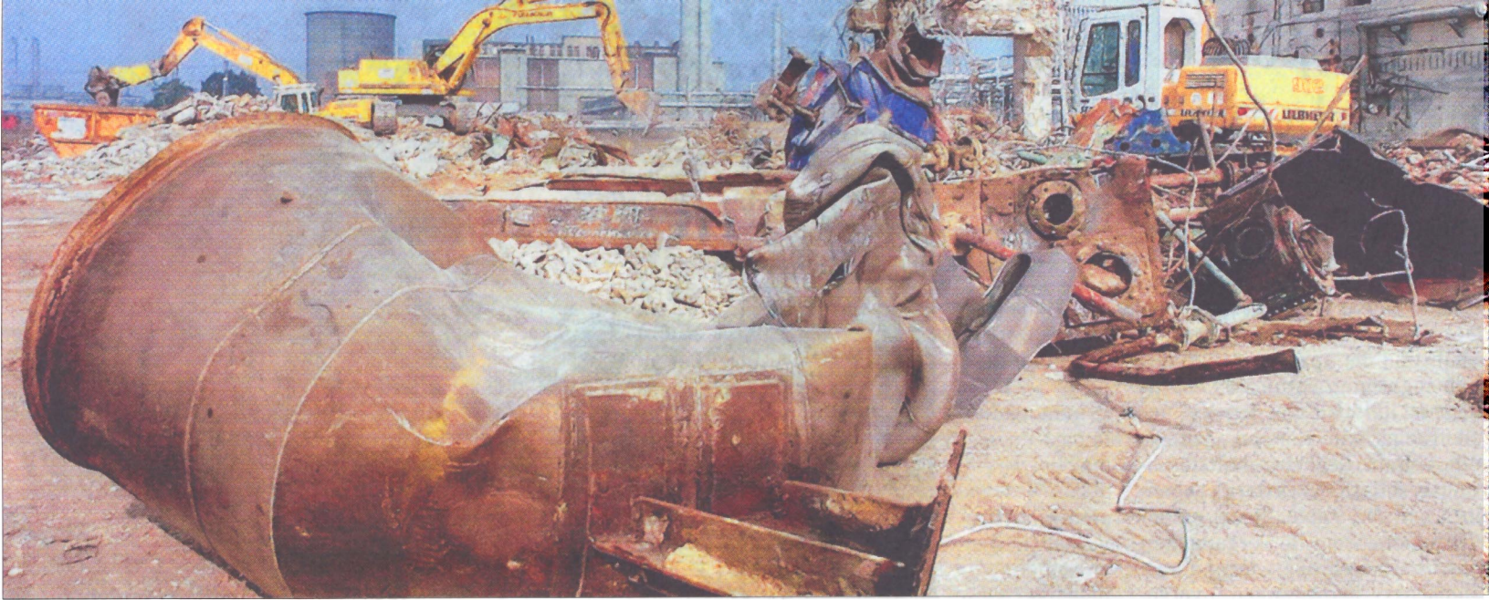
Auf dem Gelände der einstigen Salpetersäureanlage, die abgerissen wird, soll 2007 die Biodiesel- und Glycerin-Produktion starten.
