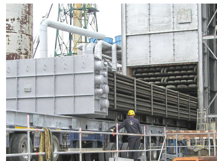
Montage des neuen POR-Bündels in der Ammoniak-Anlage 1
