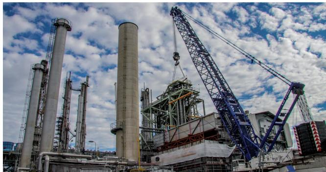
Die Bilder werden sich ähneln. So wie vor vier Jahren der kalte Ast an einem Primärreformer ausgetauscht wurde, passiert das diesmal mit einem heißen Ast. Die neuen Module müssen nach Piesteritz transportiert werden – inklusive erheblichen Aufwands für den Schwertransport.
